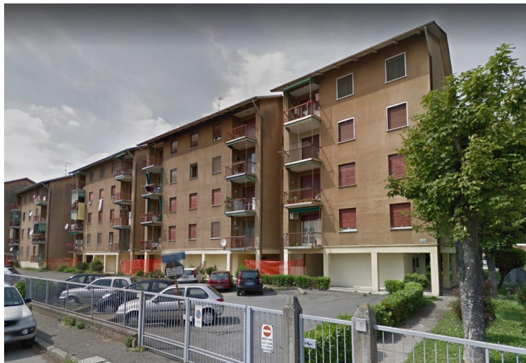
59. PAVIA, Via Zanella 1
